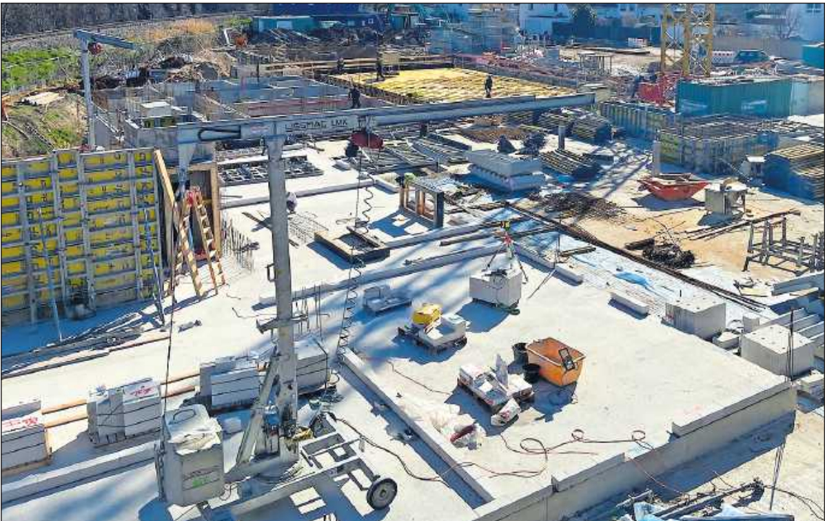
Baustelle: Vorne entsteht eines der vier Punkthäuser.
