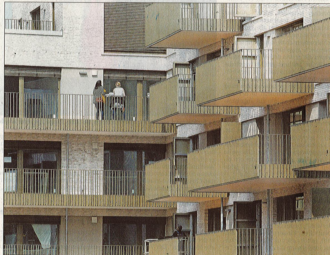
Es darf investiert werden: Wohnungen im Quartier „Am Fluss“ kurz nach deren Freigabe 2019. ARCHIVFOTO: LENZ
