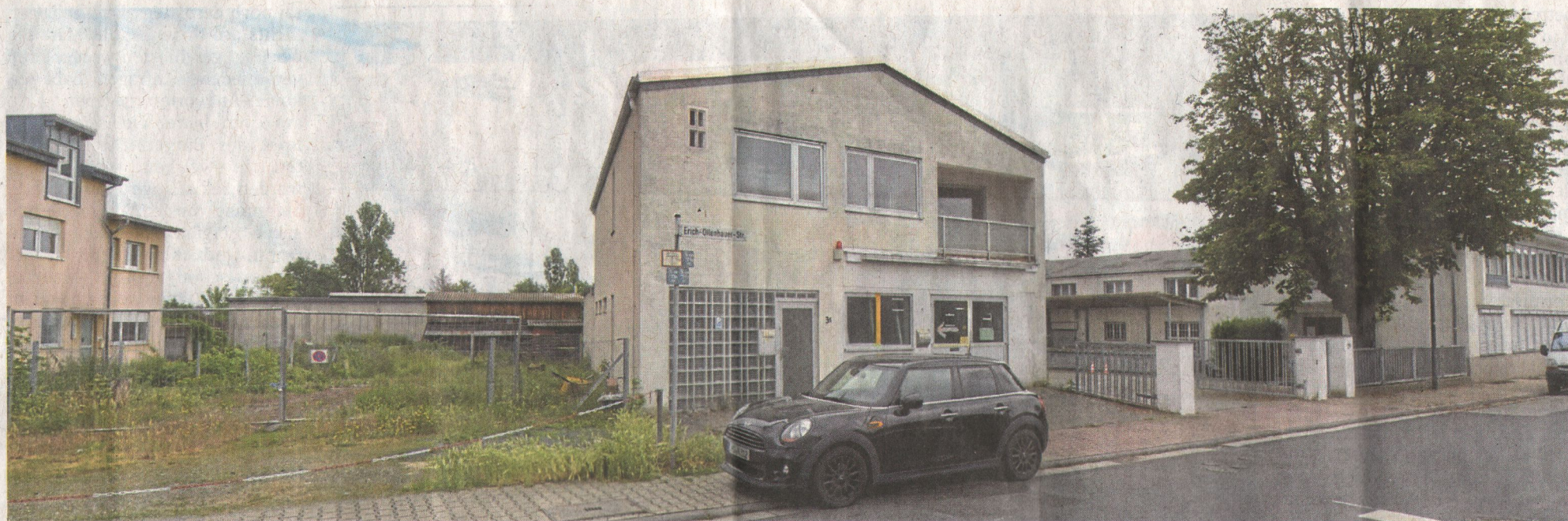
Acht Gebäude sollen auf dem Areal der alten Glasfabrik Platz finden.
