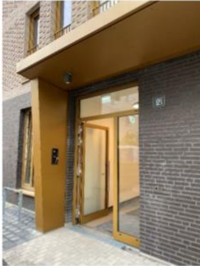
22.04.2021 – Montage des Vordachs über dem Hauseingang Petterweilstraße 21.
