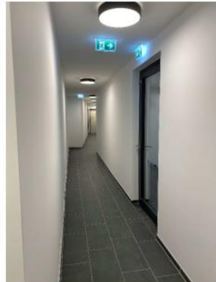
16.03.2021 – Vorbegehungen der Flure vom 1. – 4. Obergeschoss für die Abnahme.
