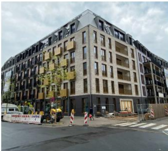
01.04.2021 – Fassadenansicht Ecke Burgstraße / Eichwaldstraße.
