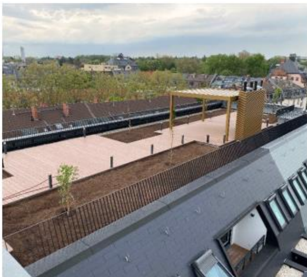
11.05.2021 – Modellieren des Geländes und anpflanzen der Sträucher und Bäume auf der Dachterrasse.
