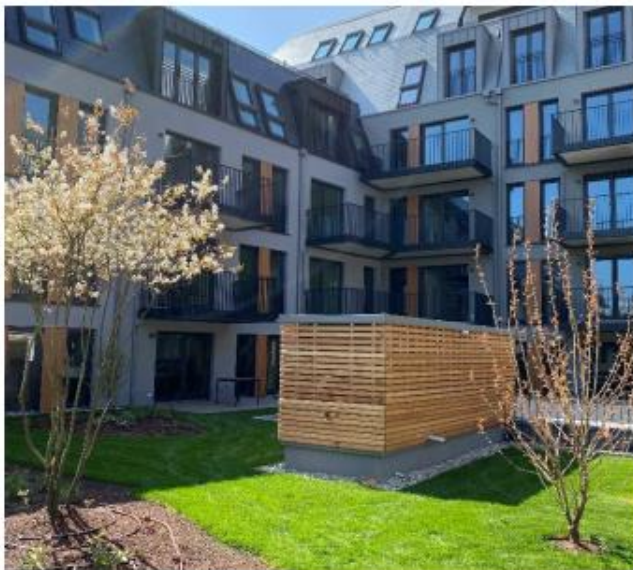
19.03.2021 – Ansicht Innenhof Richtung Eichwaldstraße.
