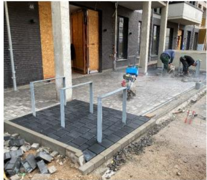
01.04.2021 – Pflasterarbeiten im Bereich Hauseingang Eichwaldstraße 68 und Gewerbeinheit 5.
