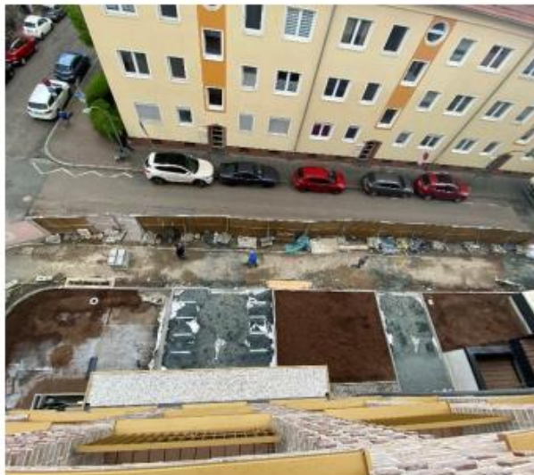
27.04.2021 – Abbau der Sanitärcontainer an der Ecke Eichwald- / Petterweilstraße.
