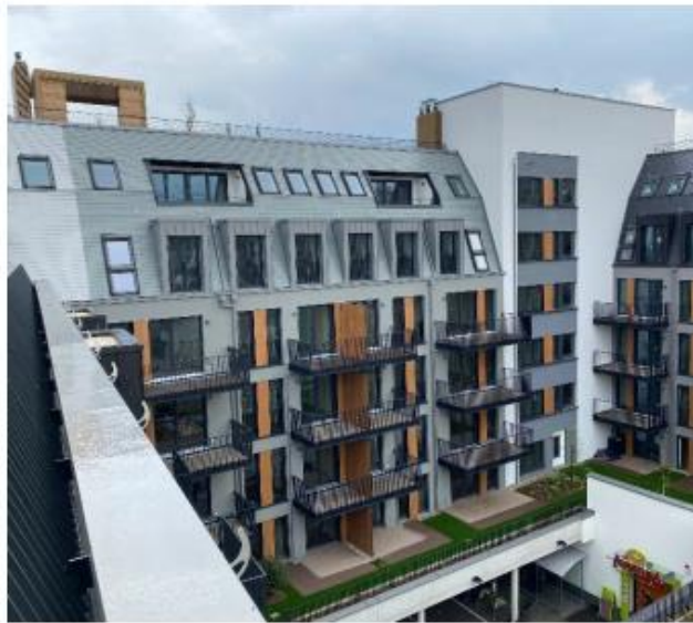
12.04.2021 – Ansicht der Balkone.
