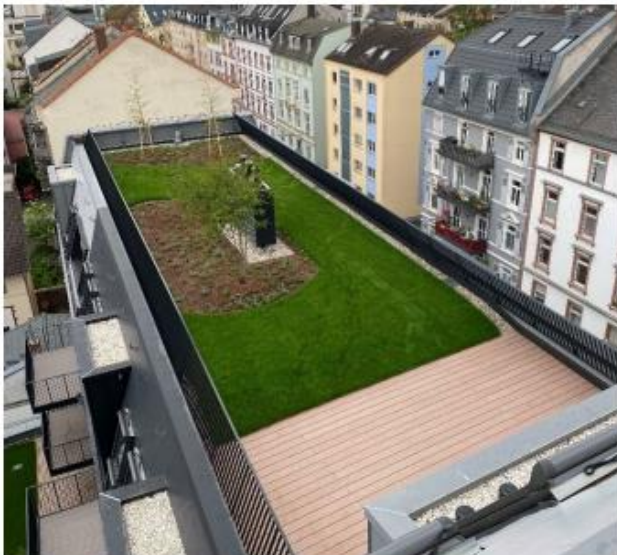
31.03.2021 – Ansicht des Dachgarten oberhalb des 4. Obergeschosses.
