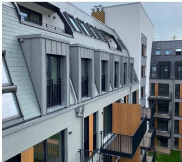
22.04.2021 – Ansicht der Dachfläche Innenhof.
