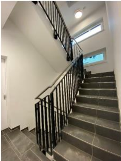
07.05.2021 – Treppenhaus und Flure wurden in Vorbereitung auf die Abnahme vorbegegangen.
