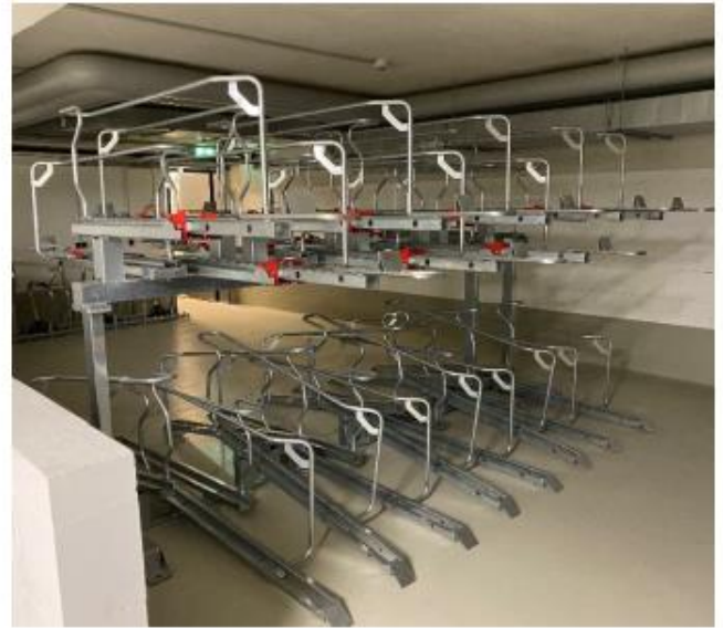
20.04.2021 – Montage der Fahrraddoppelparker in der Tiefgarage.
