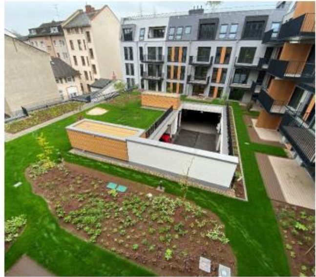
18.03.2021 – Ansicht Innenhof Richtung Petterweilstraße.
