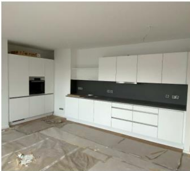
01.04.2021 – Montage der Küchen im 5. und 6. Obergeschoss.
