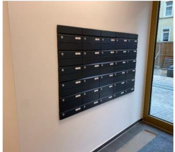
11.05.2021 – Ansicht der Briefkastenanlage im EG Petterweilstraße.
