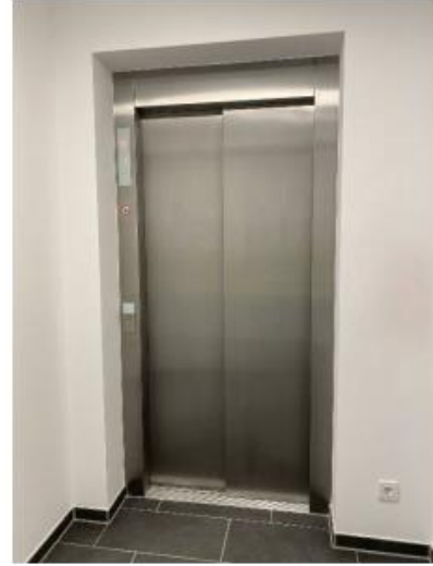
07.05.2021 – TÜV-Abnahme des Aufzuges im TRH B erfolgte am 07.05.2021.
